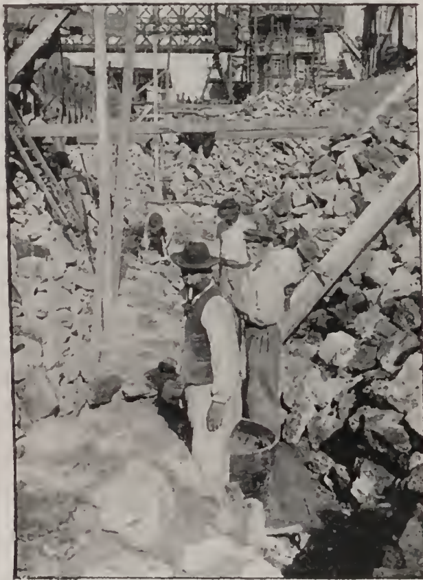
Dans la tranchée.
